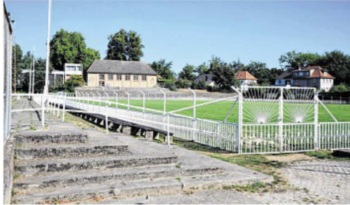
Die Sportanlage auf der Paulshöhe soll abgerissen werden und Platz schaffen für Bebauung. Die Hallen müssen bleiben. FOTO: KAWI
