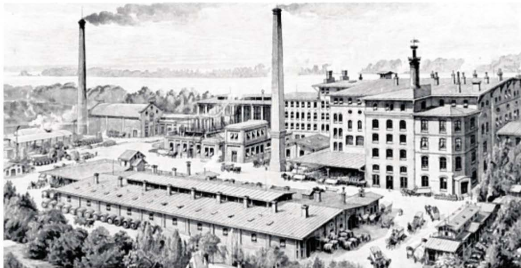
Nach einem Brand am 26. April 1882 wurde die Brauerei Paulshöhe, die zu dieser Zeit von August Spitta geführt wurde, wieder aufgebaut und erweitert.
